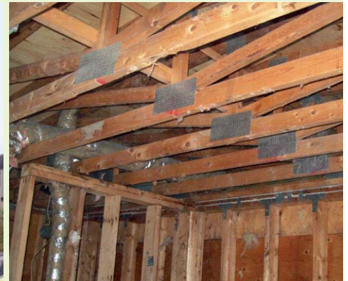
Les fermes de toit (truss) de l'ancien poste de contrôle routier de Candiac ont été récupérées pour un réemploi.
