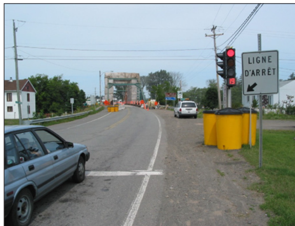
Feux de circulation pour travaux
