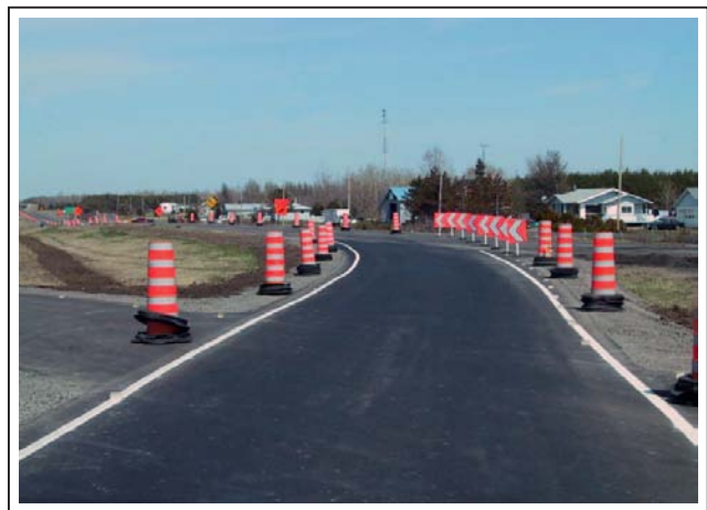
Utilisation des chevrons de direction dans la courbe extérieure
