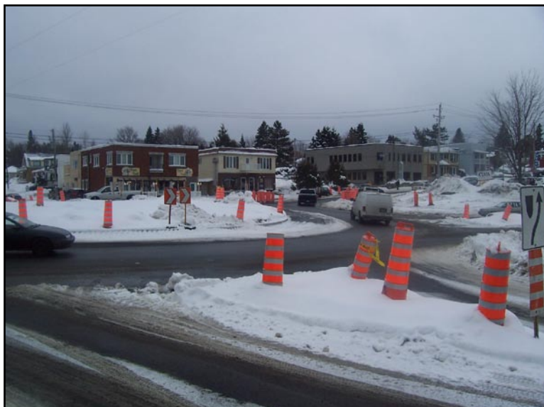
Le nouveau carrefour giratoire pendant sa construction (3 décembre 2008).
