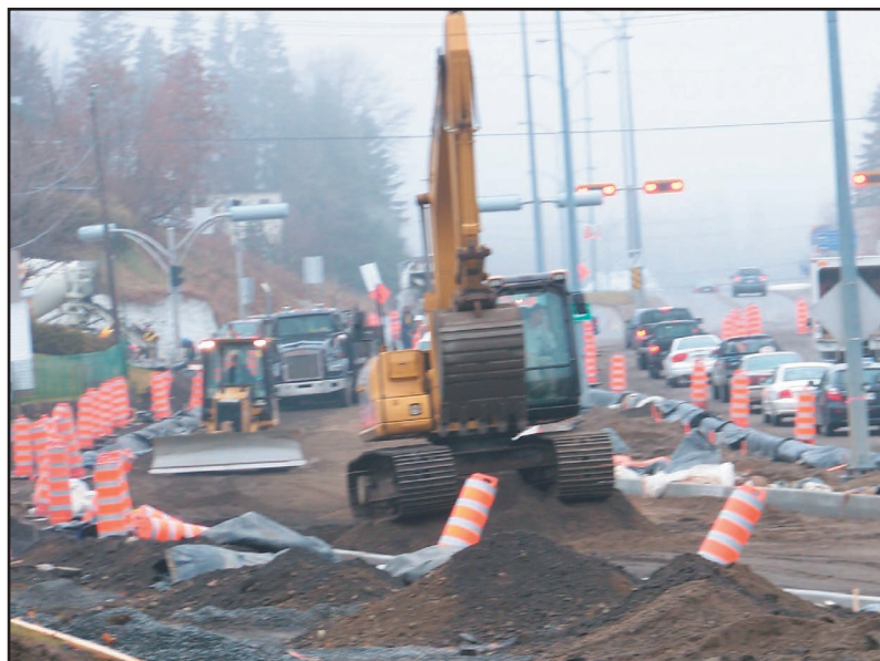
Le nouveau carrefour giratoire pendant sa construction (14 novembre 2008).
