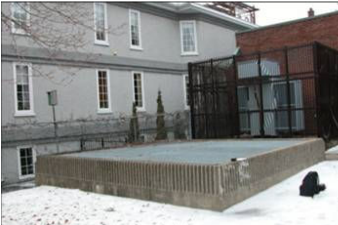
Poste de ventilation Decelles
