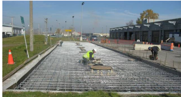
Installation de la dalle de propreté au centre de transport LaSalle
