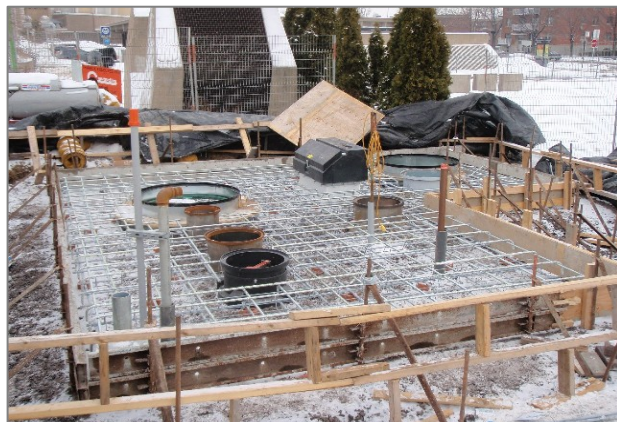
Installation du réservoir de diesel souterrain- Centre d'attachement Viau
