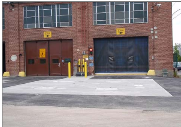
Réservoirs de diesel souterrains - CT St-Denis
