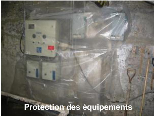
Une méthode de travail a été mise au point et consiste à confiner les eaux de lavage dans la chambre mécanique à l'aide de structures de rétention et à récupérer par pompage ces rejets huileux dans un camion-citerne stationné aux abords de la station. Outre la réduction des impacts à la source, cette façon de faire permet l'utilisation de détergent et minimise les ressources requises tout en assurant un résultat très satisfaisant.
