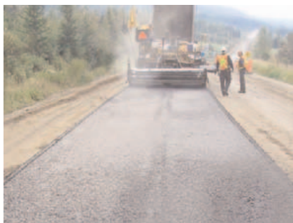
Figure 2-2 Ségrégation de la texture
