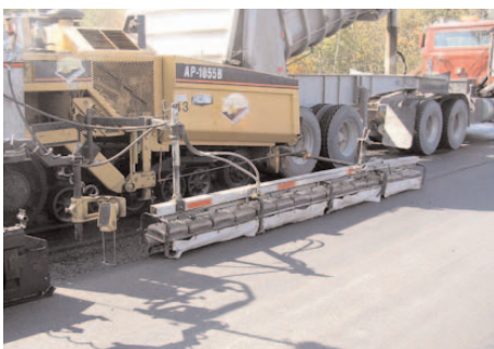
Figure 6-10 Chauffe-joint fixé sur un finisseur
