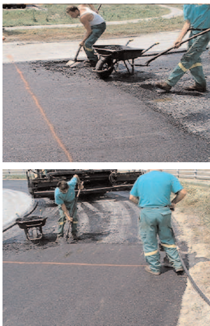
Figure 6-3 Reprise des travaux
