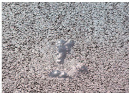
Figure 1-1 Remontée du produit de scellement
