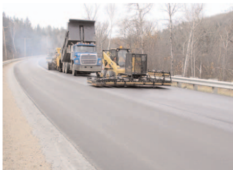
Figure 8-5 Chauffe-surface et élévation de température en surface
