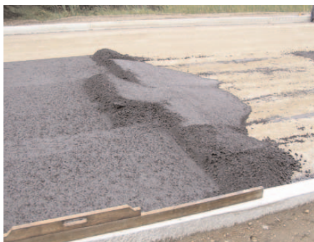
Figure 4-7 Andin d'enrobé bitumineux
