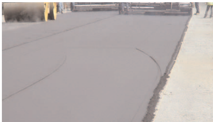
Figure 5-8 Arrêt de compaction en obliquant
