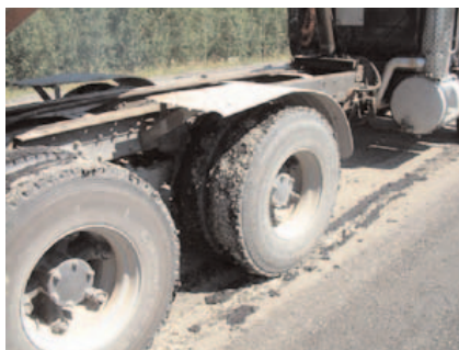
Figure 3-2 Arrachement du liant d'accrochage par les pneus
