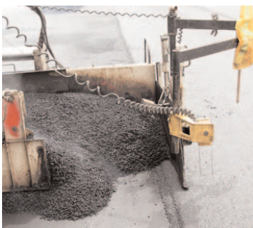
Figure 6-7 Chevauchement des bandes
