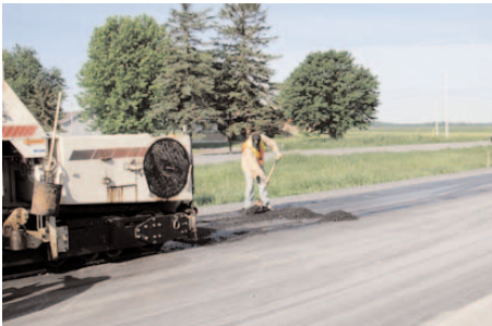
Figure 4-6 Enlèvement des amas d'enrobé
