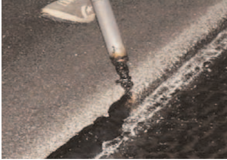
Figure 6-9 Pose d'un produit de scellement pour joint
