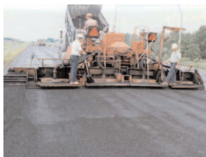
Figure 1-8 Pose d'une couche de correction
