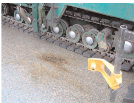
Figure 4-8 Déversement de solvant sur le revêtement
