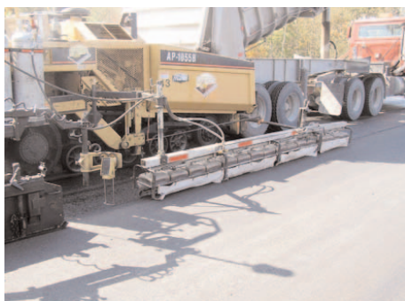
Figure 8-4 Chauffe-joint et élévation de température au joint
