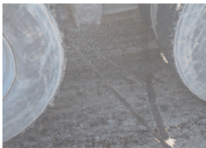
Figure 1-2 Produit de scellement collant aux pneus de camions
