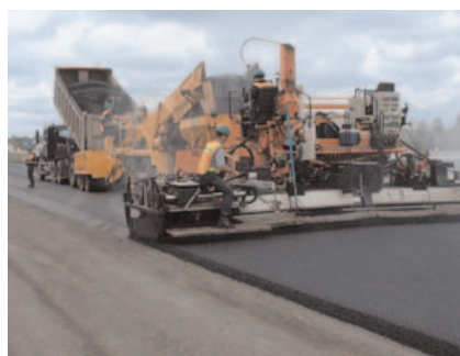
Figure 4-14 Utilisation d'un VTM avec un finisseur de grande largeur
