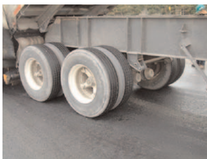
Figure 3-3 Liant d'accrochage n'adhérant pas aux pneus
