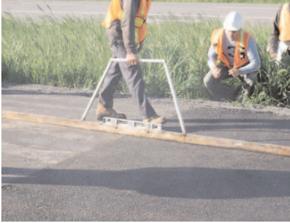
Figure 6-4 Vérification de l'uni avec la règle de 3 mètres
