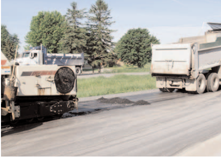
Figure 4-5 Dépôts d'enrobé devant le finisseur
