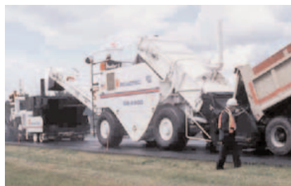
Figure 8-3 Véhicule de transfert de matériaux (VTM) et homogénéisation de la température
