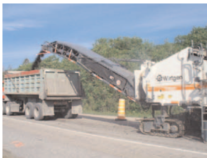
Figure 1-9 Opération de planage
