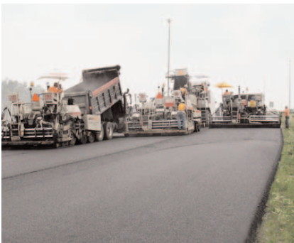
Figure 6-6 Finisseurs en échelon
