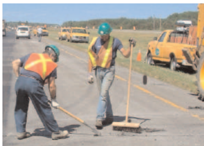
Figure 1-3 Enlèvement du produit de scellement
