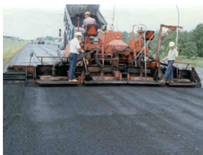
Figure 1-8 Pose d'une couche de correction
