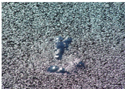
Figure 1-1 Remontée du produit de scellement
