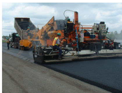
Figure 4-12 Utilisation d'un VTM avec un finisseur de grande largeur
