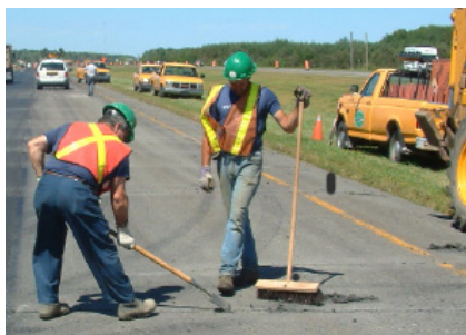
Figure 1-3 Enlèvement du produit de scellement
