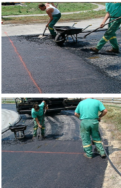
Figure 6-3 Reprise des travaux
