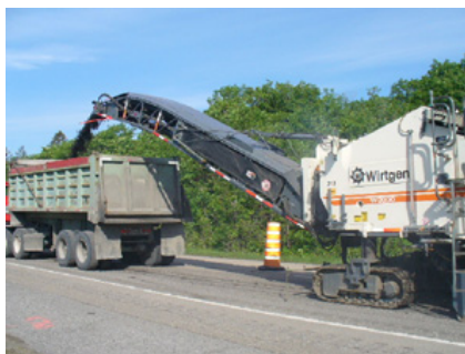
Figure 1-9 Opération de planage
