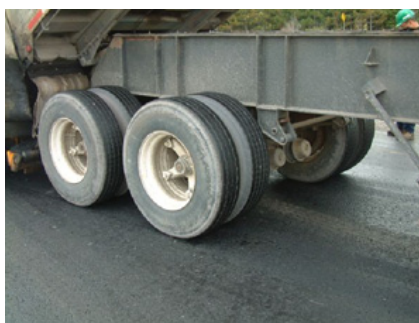
Figure 3-3 Liant d'accrochage n'adhérant pas aux pneus
