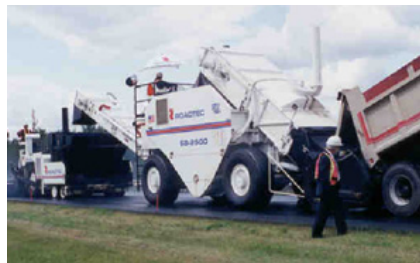
Figure 8-3 Véhicule de transfert et homogénéisation de la température
