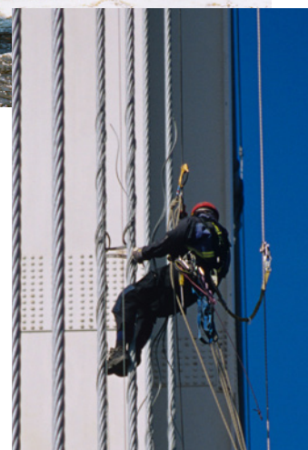
Inspection en appui sur cordes
