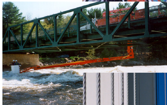
Inspection à l'aide d'une la nacelle
