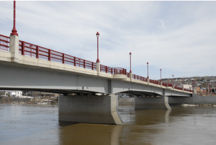
P-10861 Municipalité de Ste-Marie de Beauce au-dessus de la rivière Chaudière
