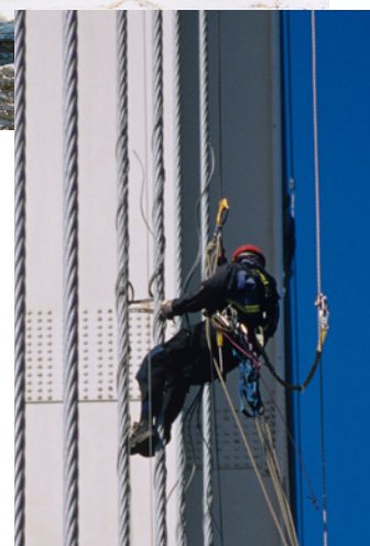
Inspection en appui sur cordes
