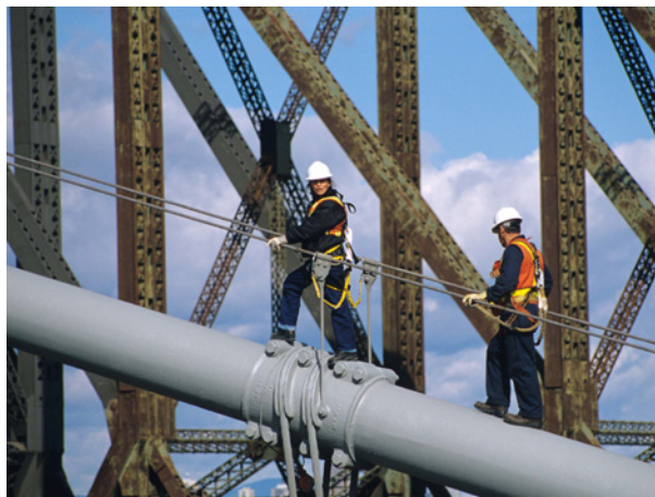
P-04296 Inspecteurs circulant sur les câbles porteurs du Pont Pierre-Laporte
