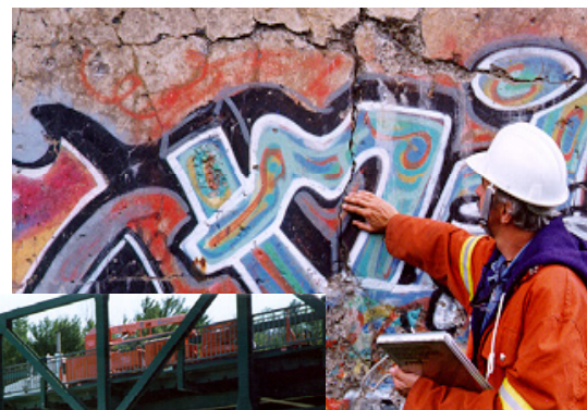
Inspection « le doigt sur la pièce »
