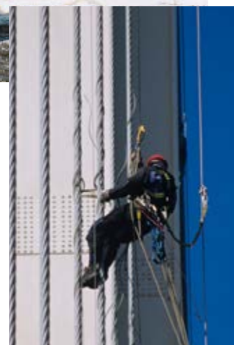
Inspection en appui sur cordes
