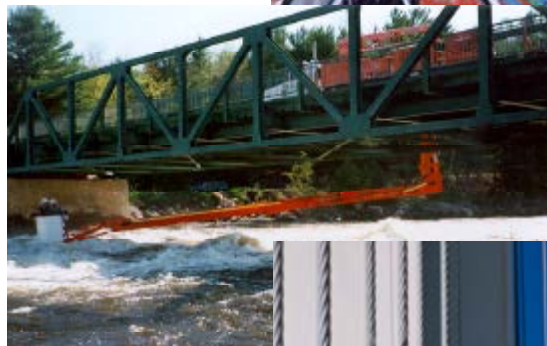
Inspection à l'aide de la nacelle
