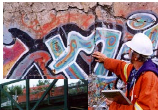
Inspection « le doigt sur la pièce »
