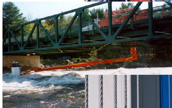
Inspection à l'aide de la nacelle
