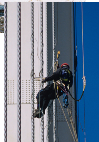
Inspection en appui sur cordes
