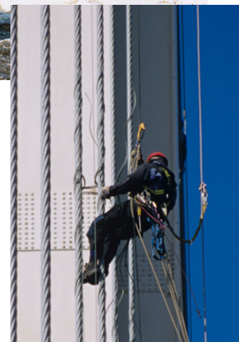
Inspection en appui sur cordes
