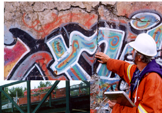
Inspection « le doigt sur la pièce »
