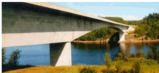
P-14679 Pont des Piles Construit en 1978 sur l'autoroute 55, au-dessus de la rivière Saint-Maurice, à Shawinigan
