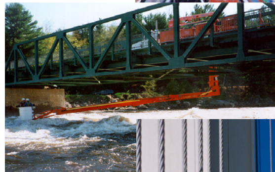
Inspection à l'aide de la nacelle
