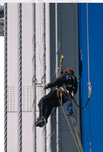
Inspection en appui sur cordes
