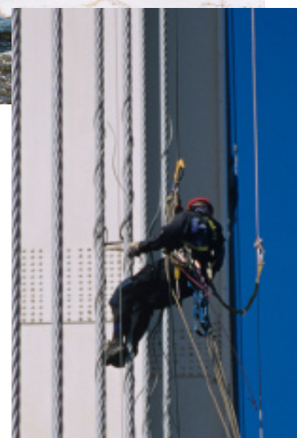
Inspection en appui sur cordes
