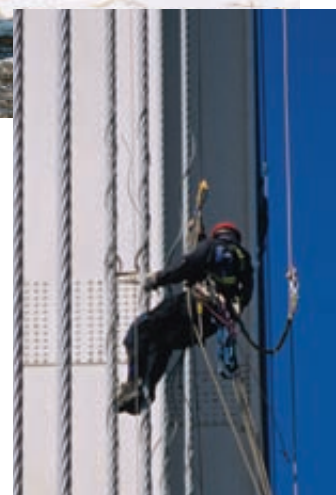
Inspection en appui sur cordes
