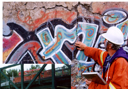
Inspection « le doigt sur la pièce »
