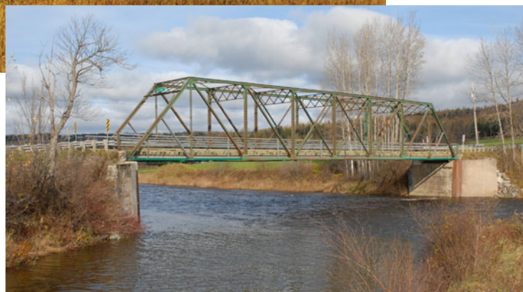
Pont de moindre envergure
