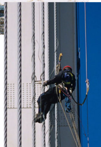
Inspection en appui sur cordes
