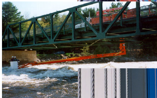
Inspection à l'aide de la nacelle
