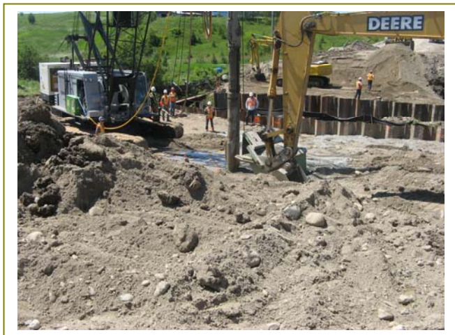
Remplacement du pont qui enjambe la rivière Chaboillez sur la route de Saint-Lambert
