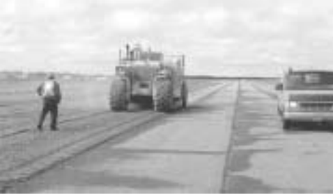
Projet d'immobilisations de Transports Canada : pulvérisation du revêtement existant d'une aire de mouvement.
