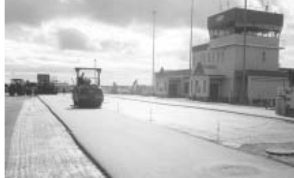
Projet d'immobilisations de Transports Canada : restauration d'une aire de mouvement.
