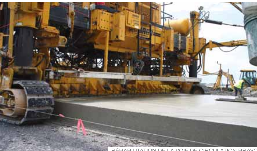
RÉHABILITATION DE LA VOIE DE CIRCULATION BRAVO
