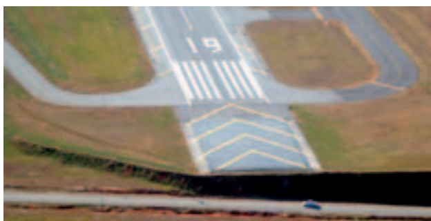
Photo d'un EMAS (Lit de l'EMAS : aire grise indiquée par les chevrons jaunes)
