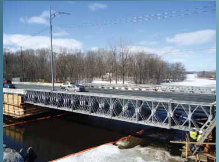
Reconstruction du pont de l'île-Thomas, dans l'axe de l'autoroute 40, à Vaudreuil-Dorion.
