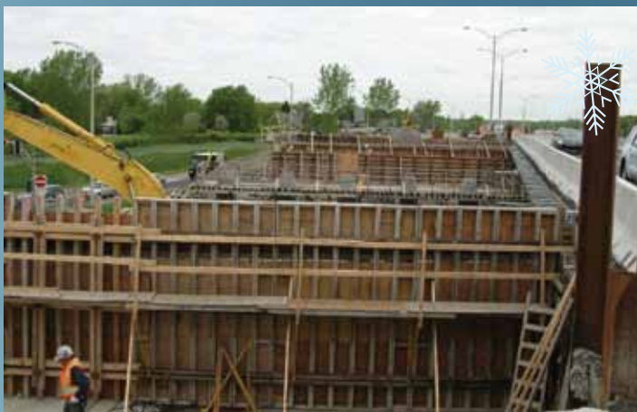
Reconstruction de la structure de l'autoroute 15, au-dessus de la rue Salaberry, à La Prairie.
