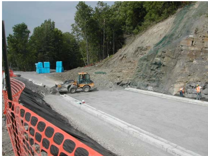
En mai 2006, on commençait la construction du passage multifonction d'une largeur de 9,8 mètres qui facilitera la circulation des chevaux, cyclistes et piétons entre les parties nord et sud du parc de la Gatineau, sur une toute nouvelle piste qui reliera le secteur du Lac-des-Fées à celui du Manoir des Trembles.
