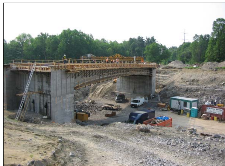
Bientôt, les citoyens (automobilistes, cyclistes et piétons) pourront déjà emprunter le nouveau pont d'étagement de la promenade de la Gatineau, qui enjambera le boulevard Saint-Laurent en construction.
