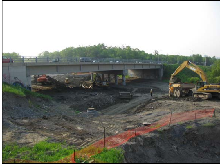
Aperçu des travaux sous le boulevard Saint-Raymond au 31 mai 2006
