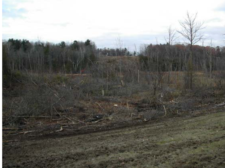
Novembre 2005 - La première étape du chantier passait par le déboisement de l'emprise du futur boulevard Saint-Laurent. Les arpenteurs ont délimité une zone de protection de 3 m de part et d'autre du corridor afin de protéger les arbres en bordure du chantier.
