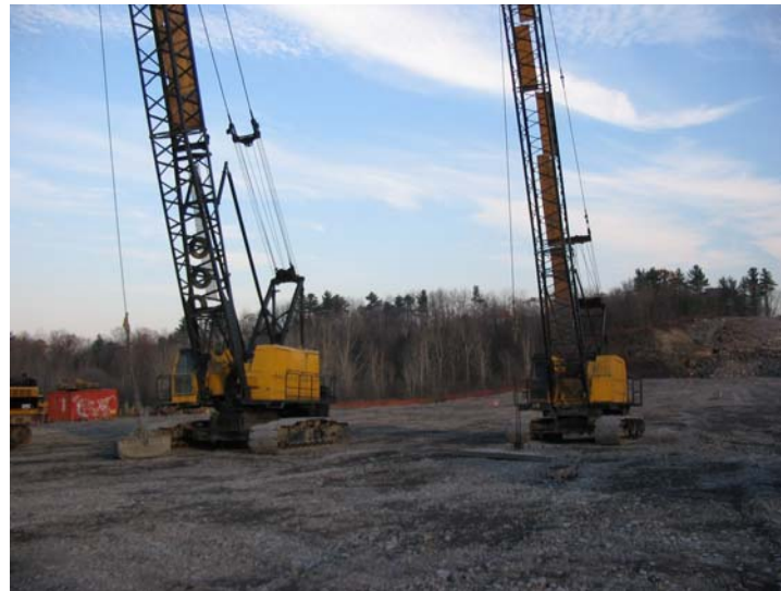
Novembre 2005 - Des grues ont été utilisées afin d'appliquer une compression dynamique pendant quelques semaines sur l'ancien dépotoir situé en plein cœur du parc de la Gatineau. Une surcharge est en place depuis janvier 2006, pour une période de 16 mois, afin de consolider les sols qui y reposent depuis plus de 30 ans.
