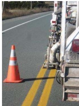
Une nouvelle technique pour améliorer la visibilité sur les routes est actuellement à l'essai sur une portion de la route 112, à Saint-Frédéric. Ce projet pilote consiste à poser de petites plaquettes réfléchissantes entre les deux lignes centrales de la chaussée. Ces délinéateurs incrustés permettraient d'offrir aux usagers une visibilité jusqu'à trois fois plus grande lorsqu'il pleut ou une fois la nuit tombée.
