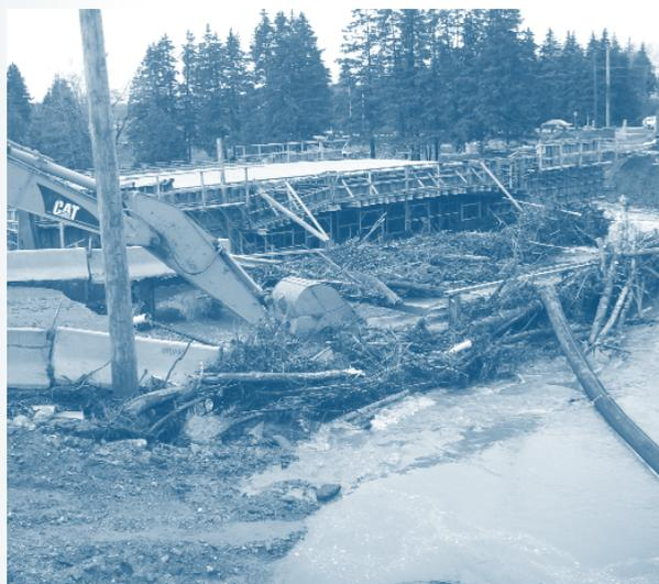
À Notre-Dame-des-Pins, le pont temporaire a été emporté par la crue des eaux et le pont en construction a subi des dommages importants.
