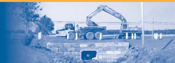
Reconstruction d'un ponceau sur la route 108 à La Guadeloupe à la suite des pluies abondantes
