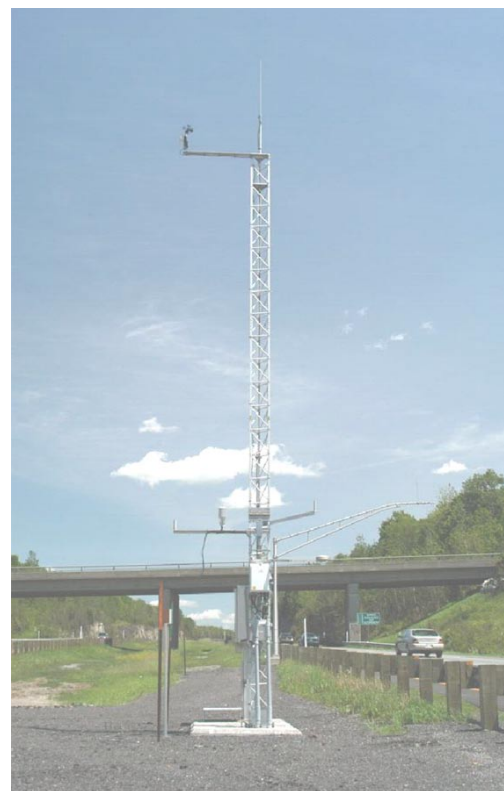
Station météo routière
