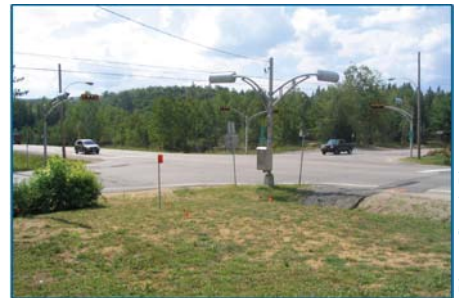
L'intersection de la montée Ryan et de la route 327 à Mont-Tremblant avant la construction du carrefour giratoire.
