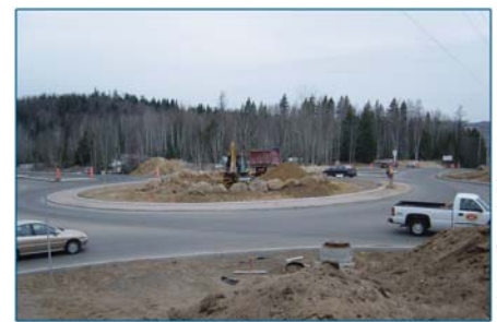
L'intersection de la montée Ryan et de la route 327 à Mont-Tremblant pendant la construction du carrefour giratoire.
