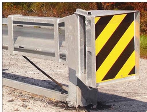
Figure 1 – Exemple de tête d'impact coulissante.
