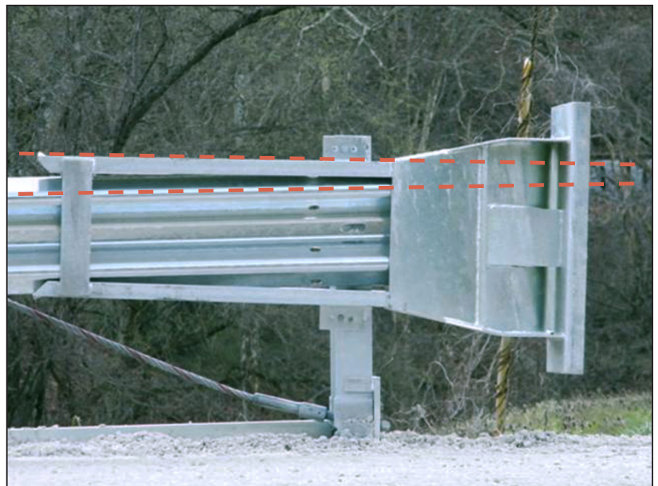
Figure 6 – Exemple d'une tête d'impact du ET Plus non alignée avec le profilé.
