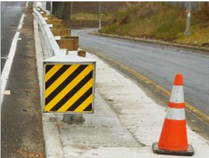
Figure 2 – Dispositif d'extrémité installé sans aucune déviation latérale.
