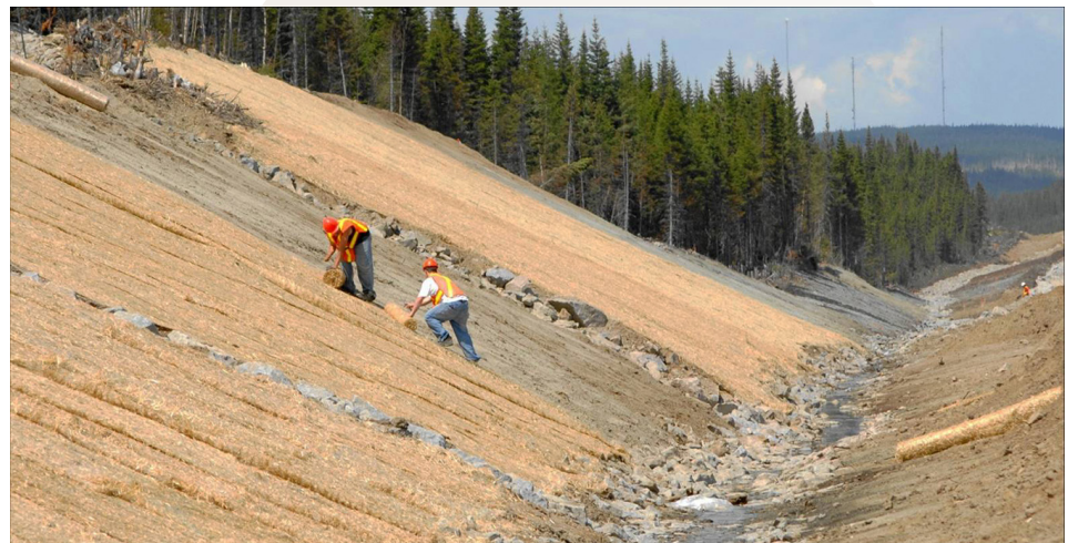
Photo 2 – Matelas antiérosion installé sur le talus de la route afin de le stabiliser et ainsi, de prévenir l'érosion et l'apport en sédiment dans les cours d'eau à proximité. (Source : MTQ)
