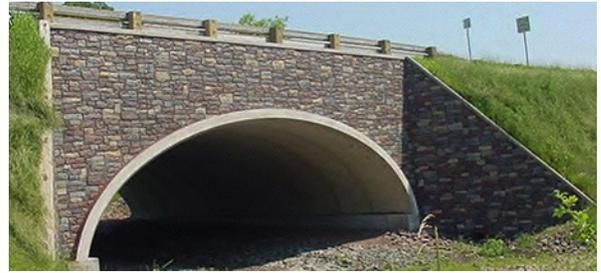
GUQ 1304 Vista Wall avec façade en panneau de béton préfabriqué
