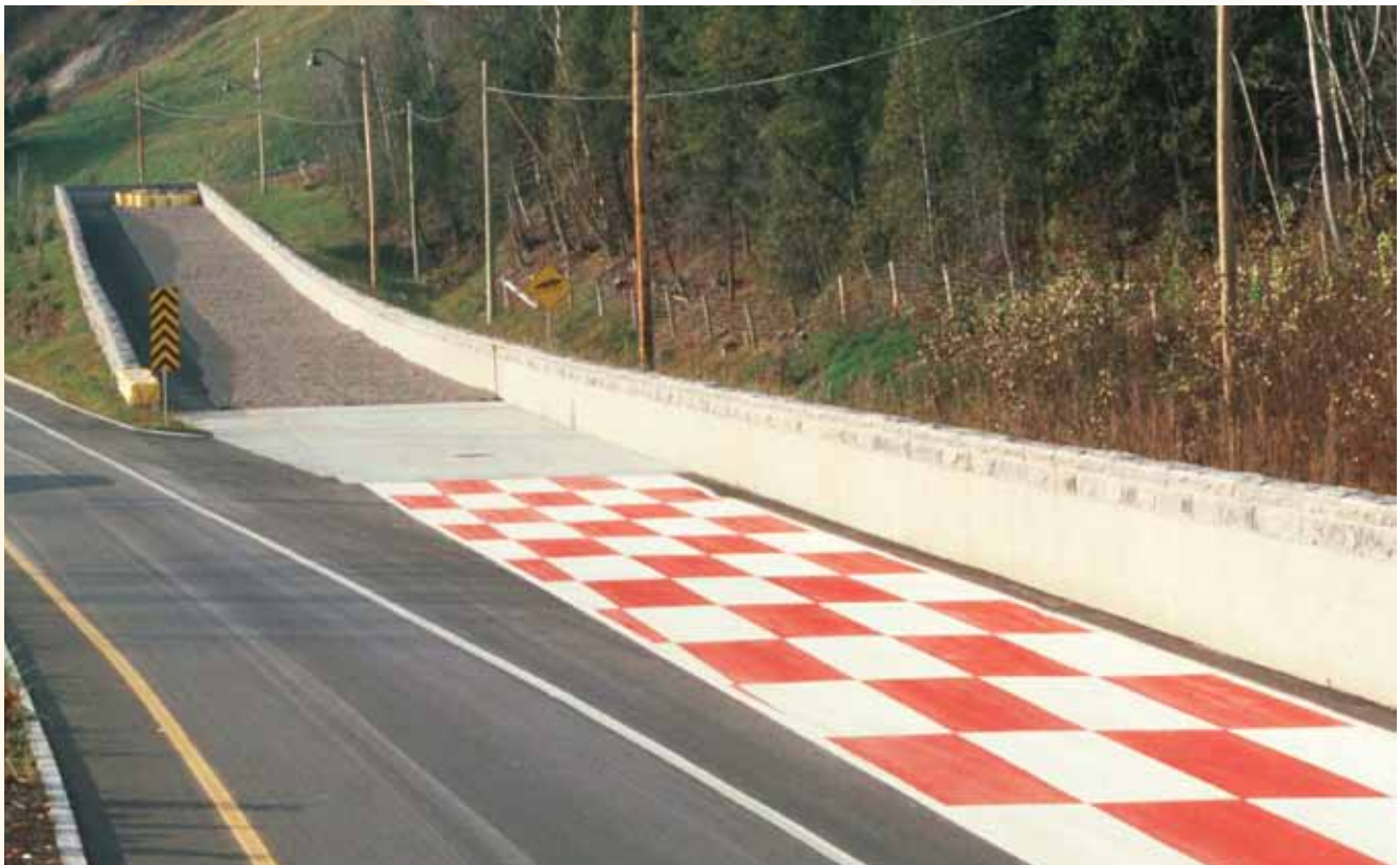
Photo 1 - Voie de secours
