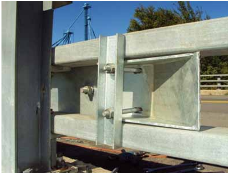
Photos 1 et 2 - Raccordement à une glissière de pont de type 43 effectué en 2010 dans le cadre d'un projet-pilote.
