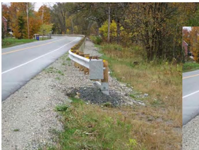
**Photo 3a – Faible pente : mauvais exemple**
