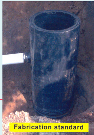
GUQ 0972 Puisard en polyéthylène à triple paroi
