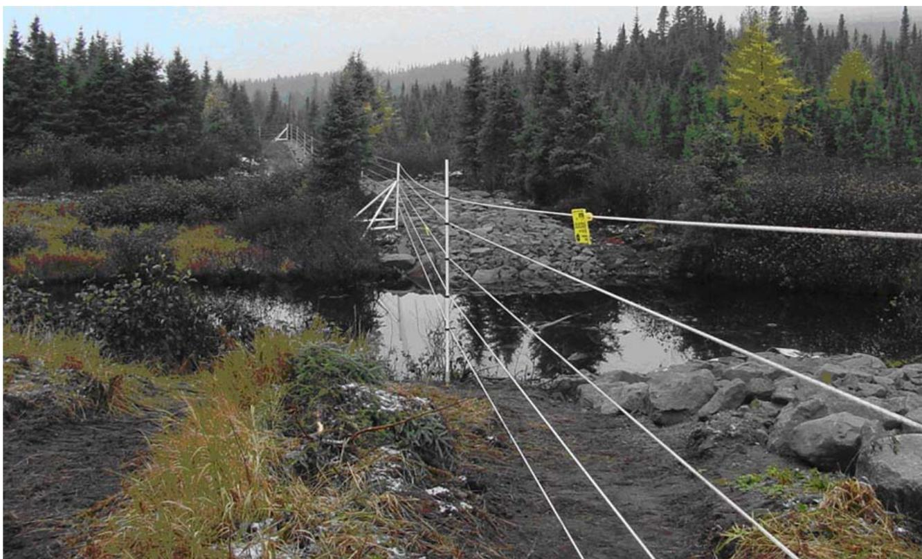
**La clôture se présente comme une structure légère mais très résistante. Il s'agit d'une série de câbles (5 ou 6) distants d'environ 30 cm soutenus par de petits poteaux en fibre de verre espacés d'environ 10 m. Des poteaux de tension sont aussi utilisés environ tous les 350 m de façon générale. Ils servent également lorsque la clôture doit changer d'angle ou franchir un obstacle.**
