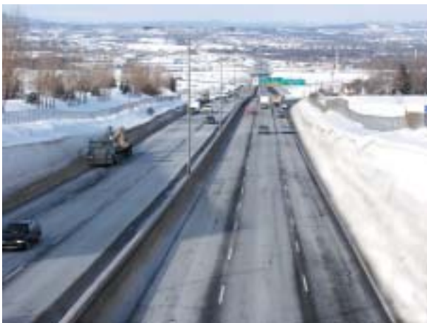
Figure 2101-1 Exemple de chaussée dégagée (autoroute)
