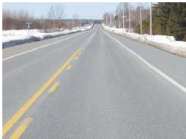
Figure 2101-2 Exemple de chaussée dégagée (route nationale, régionale, collectrice ou route d'accès aux ressources)
