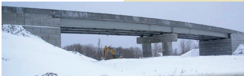
The Rang Saint-Régis Sud overpass.
