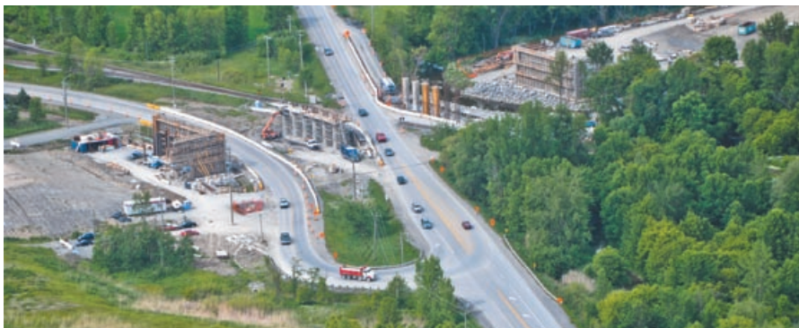
Bridge spanning rivière de la Tortue
