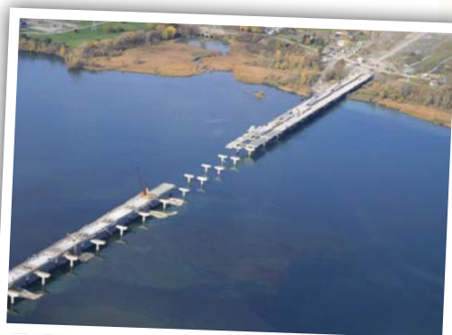
Vue aérienne de la rive nord du pont Saint-Laurent.
