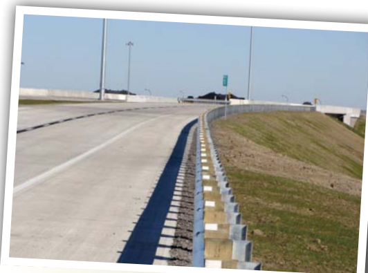
Tronçon Jean-Leman : pont d'étagement de l'autoroute 30 en direction ouest.
