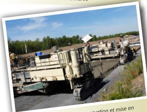
Construction des chaussées, excavation et mise en place de pierres, à l'est du pont ferroviaire
