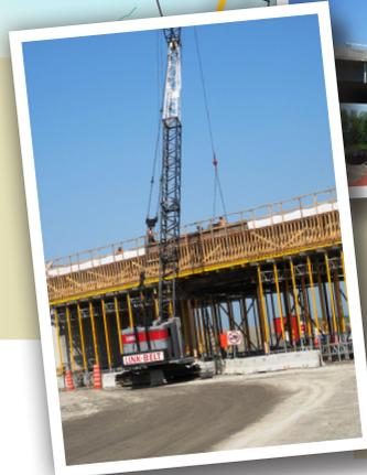
Construction du pont d'étagement du chemin Saint-Pierre, qui sera achevé au cours de l'été. L'équipe en place travaille actuellement au décoffrage de la dalle et au coffrage des dispositifs de retenue.
