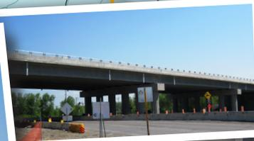
Pont de l'autoroute 30 passant au-dessus de la rivière de la Tortue, de la montée de la Saline et du rang Saint-Ignace. Il reste des travaux de finition à effectuer, notamment la pose des glissières de sécurité, l'asphaltage et les dalles d'approche.
