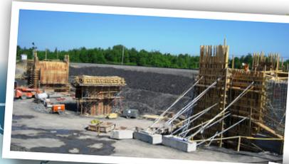
Construction des culées et de la pile du pont d'étagement ferroviaire du Canadien Pacifique. L'autoroute 30, qui sera à cet endroit en dépression, passera sous le pont.
