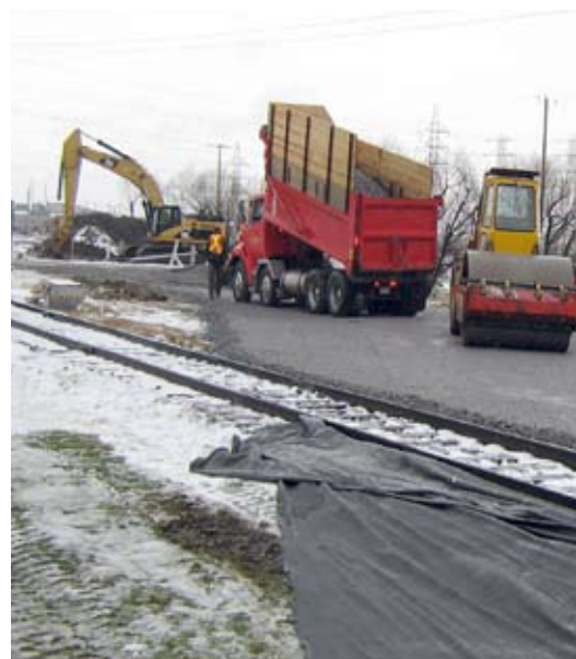
Installation de membranes et pose de pierre en vue de la construction de la voie ferrée.
