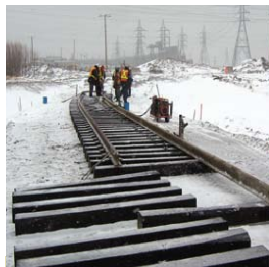
Installation de traverses de bois sous les rails par l'entrepreneur de Transports Québec.
