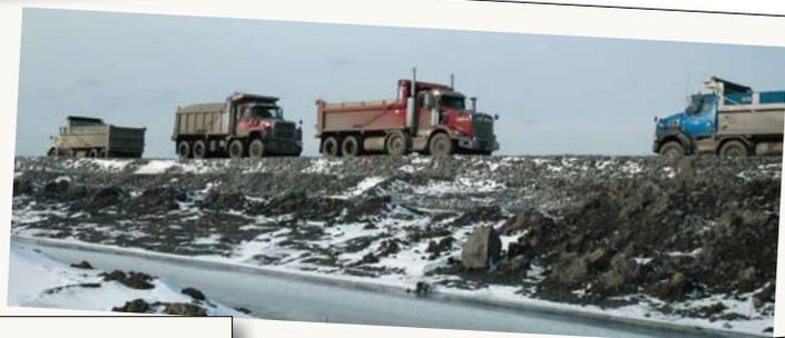
Au total, ce sont environ 400 000 tonnes de matériaux qui seront déposées sur le site du chantier. Il s'agit de la consolidation et de la construction de 1,3 km de chaussée, en plus du 1,1 km de l'échangeur, pour un total construit de 2,4 km en juillet 2008.
