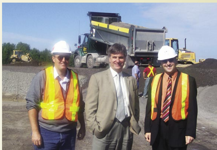
M. Fournier a visité le chantier du chemin de la Haute-Rivière le 25 août dernier en compagnie de M. Yves Melanson, chargé de projet du MTQ à la Direction de l'Ouest-de-la-Montérégie, et de M. Hubert Dubois, directeur associé chez Séguin (Séguin-Tecsult est chargé de la surveillance du chantier).
