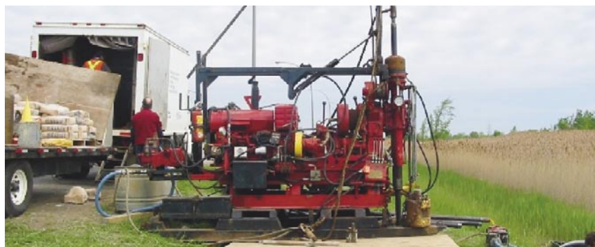
L'équipement utilisé pour effectuer ce type de forage dans les argiles sensibles.
