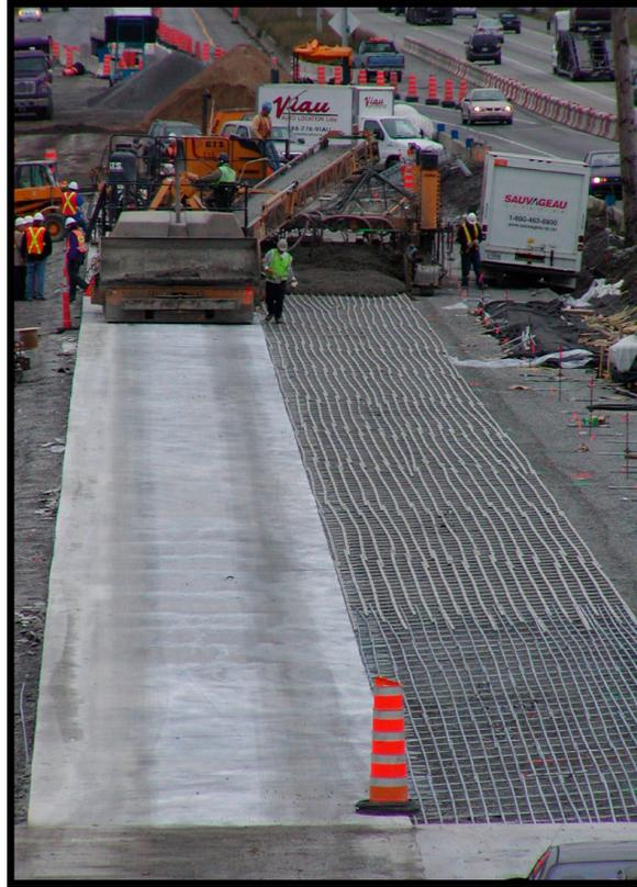
Figure 4 – Pose du béton sur l'armature de PRFV dans la voie de gauche
