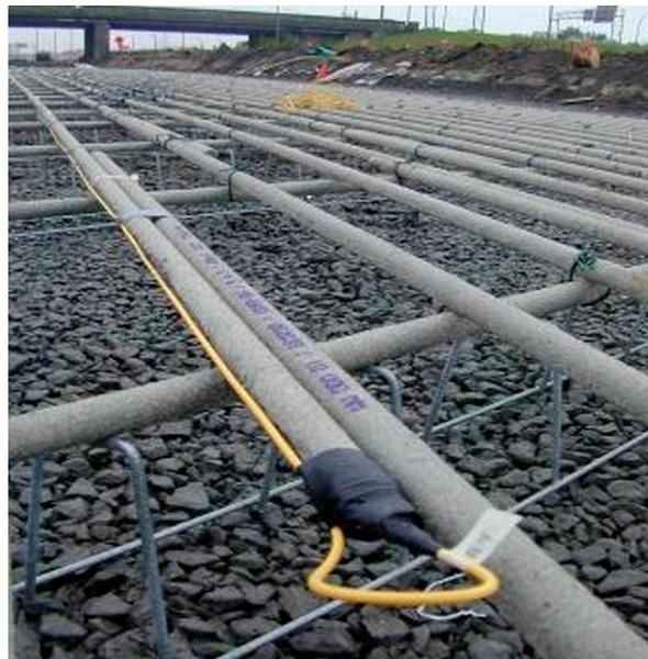
Figure 7 – Capteurs à fibres optiques pour les mesures de déformation
