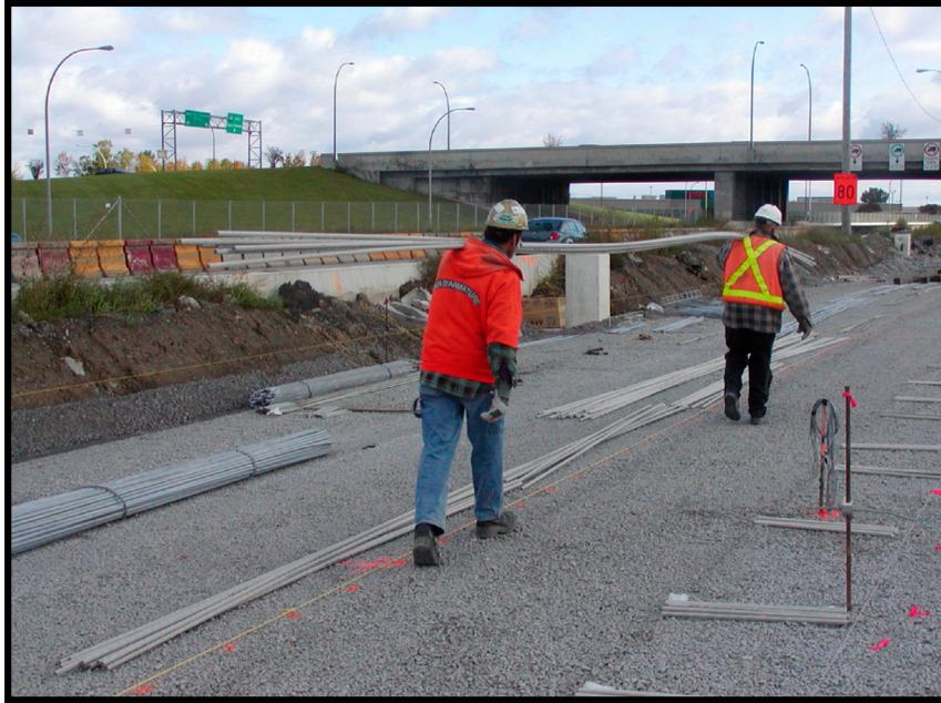
Figure 2 – Manipulation des barres d'armature de PRFV
