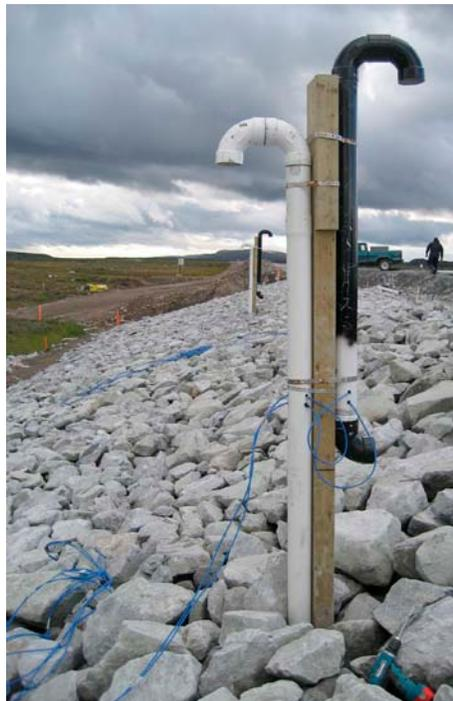
**Figure 12 – Mise en place du système de drain thermique à Tasiujaq**
