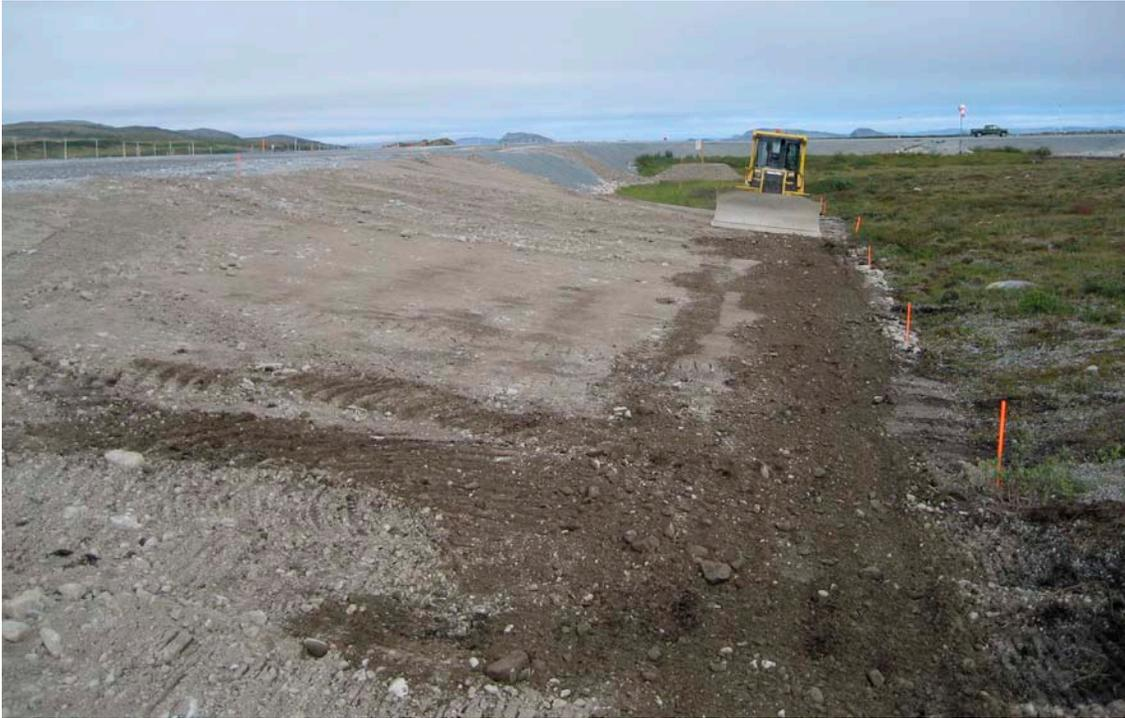
Figure 11 – Mise en place de la section de remblai à convection et du système de ventilation à Tasiujaq
