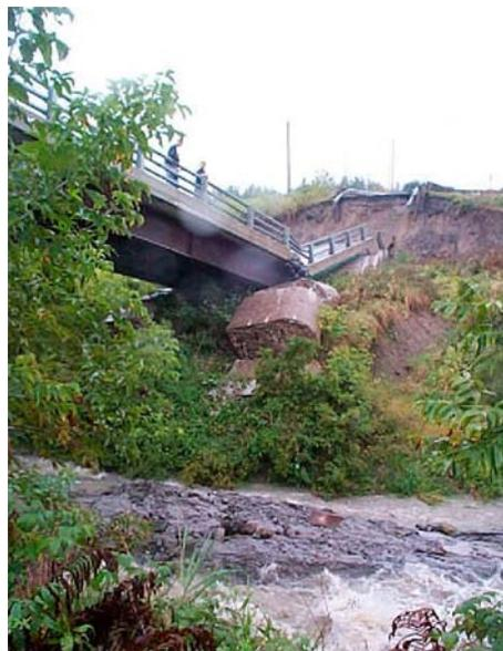
**Figure 3 : Exemple d'un glissement rotationnel profond ayant endommagé les structures d'un pont, rivière Salvail, 2000**
