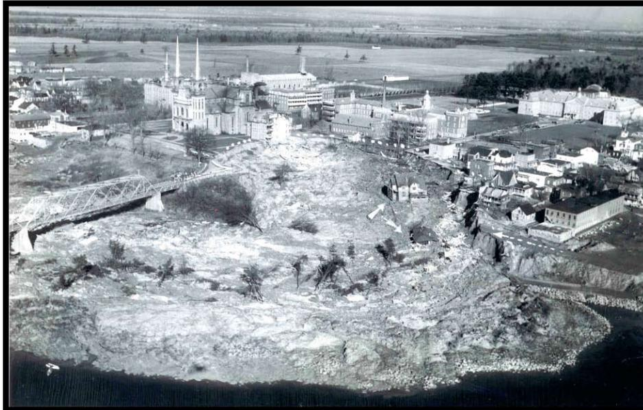
**Figure 4 : Exemple d'une petite coulée argileuse ayant endommagé une partie du centre-ville de Nicolet, en 1955**
