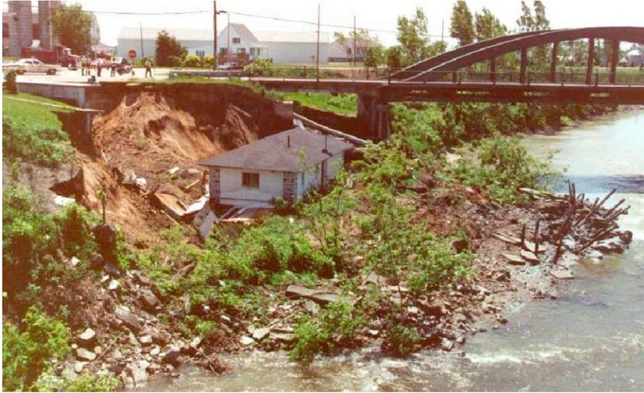
**Figure 2 : Exemple d'un glissement rotationnel profond typique dans des sols argileux, en bordure d'un cours d'eau, Maskinongé, 1990**
