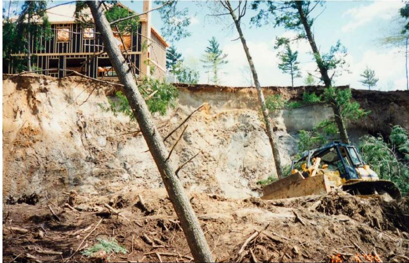
**Figure 5 : Exemple d'un glissement de terrain récent déclenché par la mise en place en sommet de talus d'un remblai non contrôlé, à proximité d'une maison en construction. On voit au premier plan les matériaux de remblai sur lesquels repose le bouteur qui a été entraîné avec le mouvement des débris lors de la rupture.**
